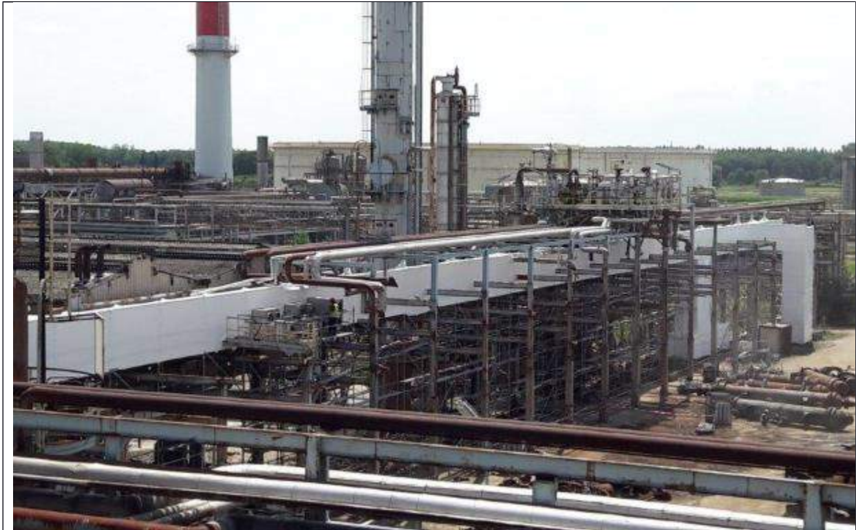
Figure 7 : Vue du désamiantage d'un ensemble de conduites sur la raffinerie
