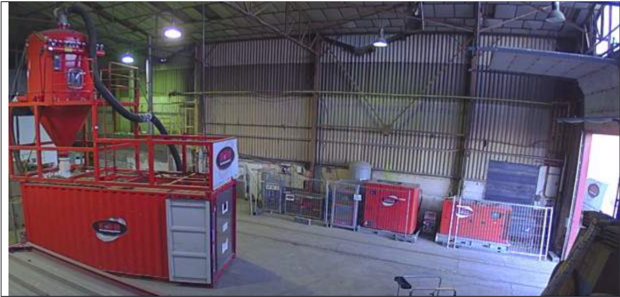
Figure 3: Vue du séparateur air/grenaille Balbigny
