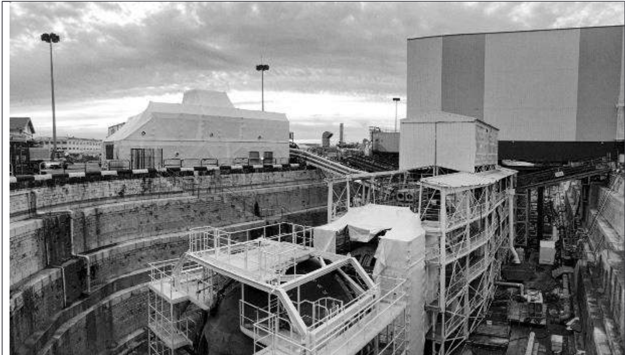
Figure 6 : Vue de l'installation de grenailage et de la zone d'intervention
